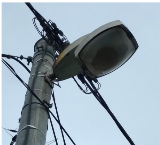
Obr. 12 Nečistoty v difuzoru
