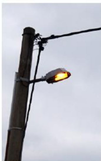
Obr. 13 Chybějící difuzor
